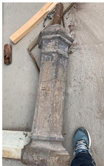
*Рис. 4. Граненый пьедестал с выпуском круглого сечения до реставрационных работ. Фотография Ю. А. Горелик, 2022 г.*
