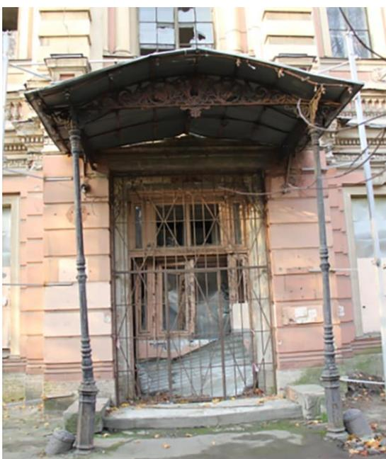
*Рис. 1. Конструкция исследуемого козырька до производства работ. Фотография 2018 г. (материалы ООО «Северо-Западное проектное бюро»)*
