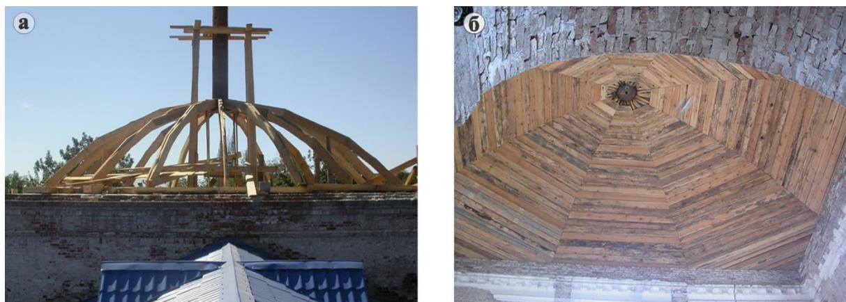
*Рис. 6. Конструкции внутреннего купола гумбаза:*
