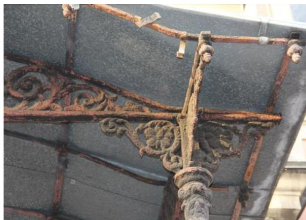
*Рис. 12. Кронштейны столбов. Узел перехода обвязки в колонну. Фото 2018 г. (материалы ООО «Северо-Западное проектное бюро»)*
