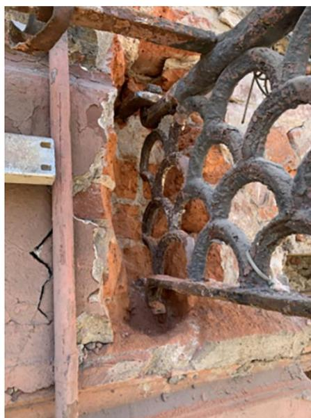
*Рис. 8. Раскрытие крепления боковой части
