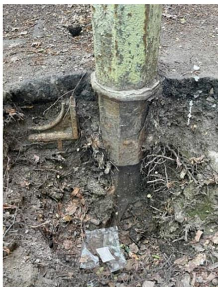
*Рис. 3. Подземная часть чугунного литого столба Дома трудолюбия (г. Кронштадт, ул. Фейгина, 7–9). Фотография Д. И. Щепетильник, 2022 г.*
