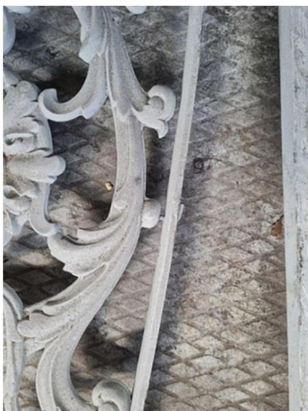
*Рис. 9. Крепление направляющей и литого элемента центрального тимпана.
