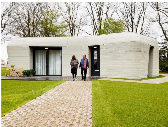
Рис. 3. Малоэтажный дом, напечатанный с помощью 3D-принтера
