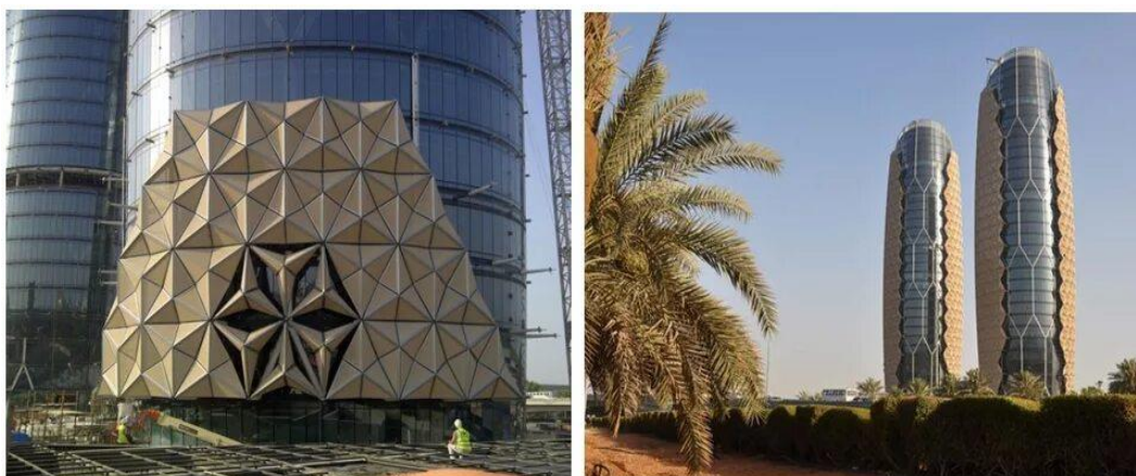
Рис. 1. Башня Al Bahar в Абу-Даби [3]
