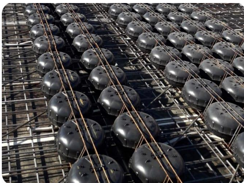
Рис. 2. Установка пластиковых пустотообразователей [2]
