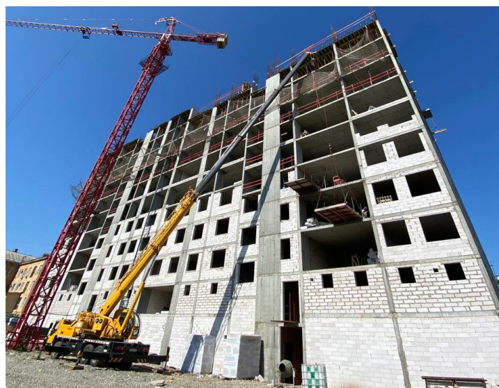
Рис. 6. Монтаж инженерных коммуникаций
