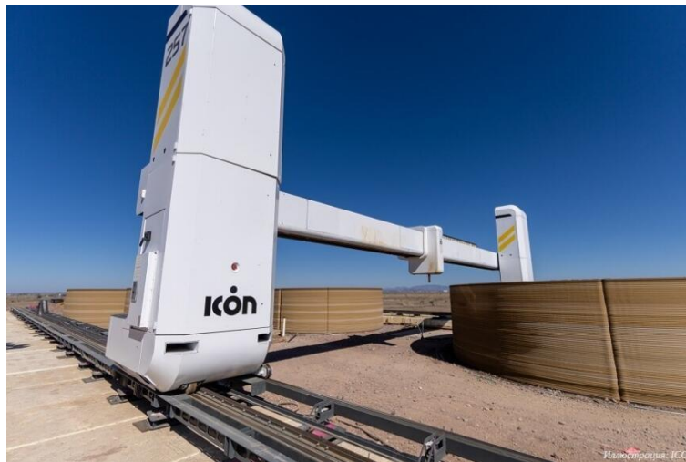
Рис. 1. Портальная система 3D-принтера
