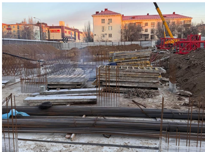
Рис. 4. Устройство фундаментов
